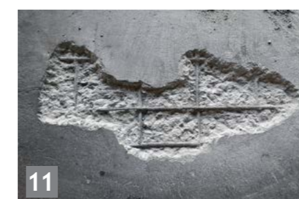
11 Ремонт і відновлення бетону
