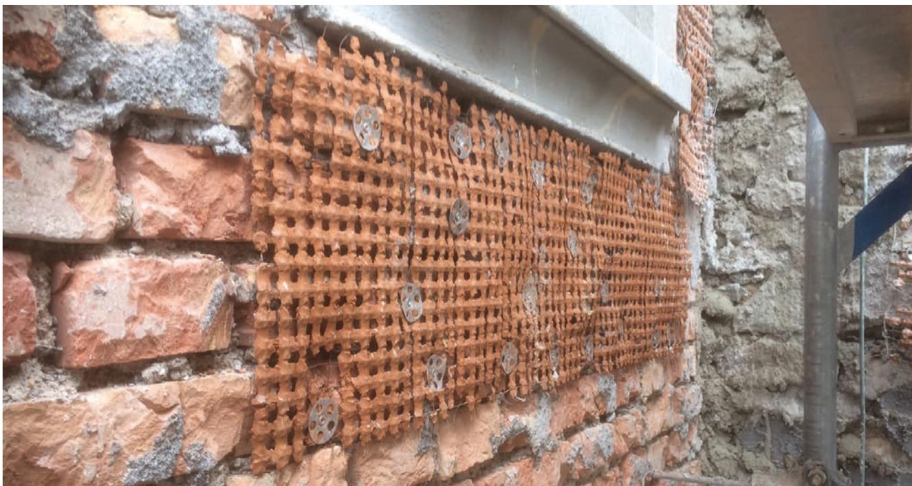
Après les travaux d'enduit de fond et un séchage suffisant sur les supports d'enduit (en général 2 à 3 semaines), l'enduit de finition peut être appliqué. Il convient d'utiliser des enduits de finition minéraux.
