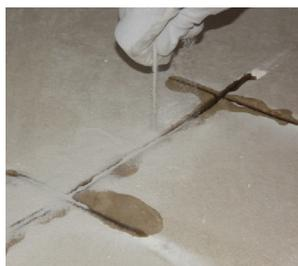
Dès que la coupe est remplie, la résine doit être saupoudrée de sable de quartz (granulométrie d'environ 0,2 à 0,7 mm) pendant le temps de prise/séchage.
