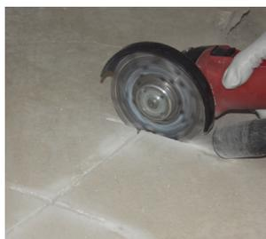
Pour assainir la fissure à long terme, suturer par exemple au moyen d'agrafes ondulées en acier inoxydable pour chape. Afin de les placer, il faut faire des entailles d'environ 10 cm perpendiculairement à la fissure, à intervalles de 20 à 30 cm, avec une meuleuse d'angle.
