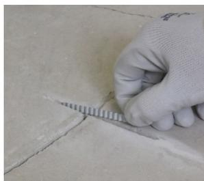
Dès que toutes les fissures et fentes découpées sont exemptes de poussière et de graisse, les agrafes ondulées pour chape peuvent être placées dans toutes les entailles transversales. Il faut veiller à ce que les agrafes ondulées disparaissent complètement dans l'entaille. Si les agrafes ondulées ne sont pas complètement insérées dans la coupe, la fente n'est pas assez profonde et doit être retaillée et nettoyée.
