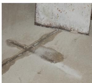
Afin d'obtenir une surface optimale pour recevoir le revêtement supérieur, les fissures sont ensuite lissées à l'aide d'une truelle ou d'une spatule. Après le durcissement, éliminer le sable de quartz non adhérent en le balayant.
