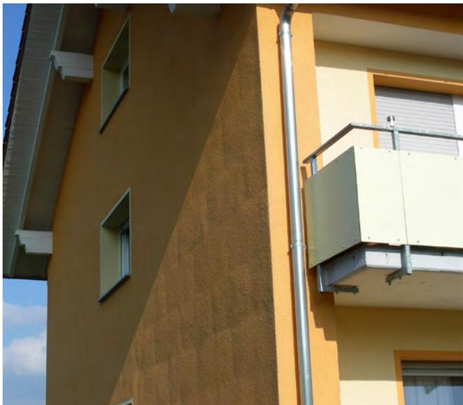
Lumière rasante sur la façade avec panneaux isolants. Les panneaux sont visibles, mais doivent être acceptés selon la norme SIA 243 "Isolation thermique extérieure crépie".
