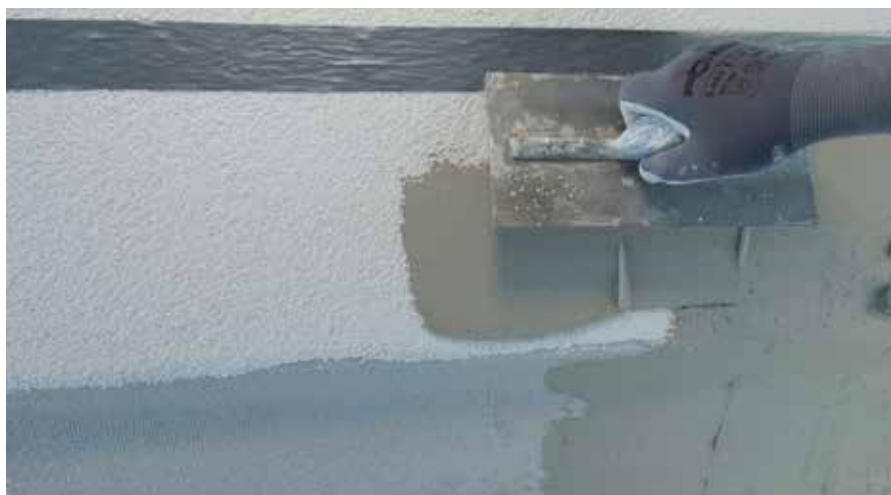
Hidroizolacija ispod terana
