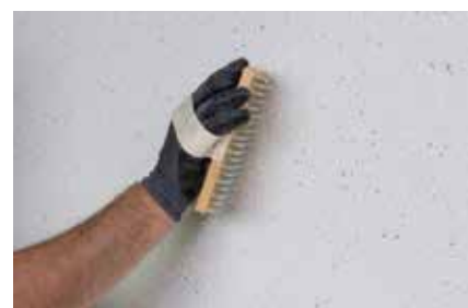
RÖFIX zaribani malteri sa grubom četkom sa čavlima
