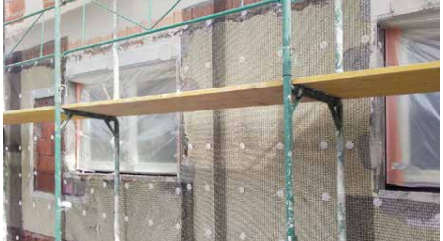
Bušenje rupa za tiplje i ugradnja tiplje
