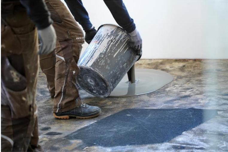
Bei kleineren Bodenflächen wird der HASIT FN 645 konventionell im Eimer angerührt und anschließend auf den Boden gegossen. Für größere Flächen ist auch das Einbringen mit Maschinenteknik möglich.
