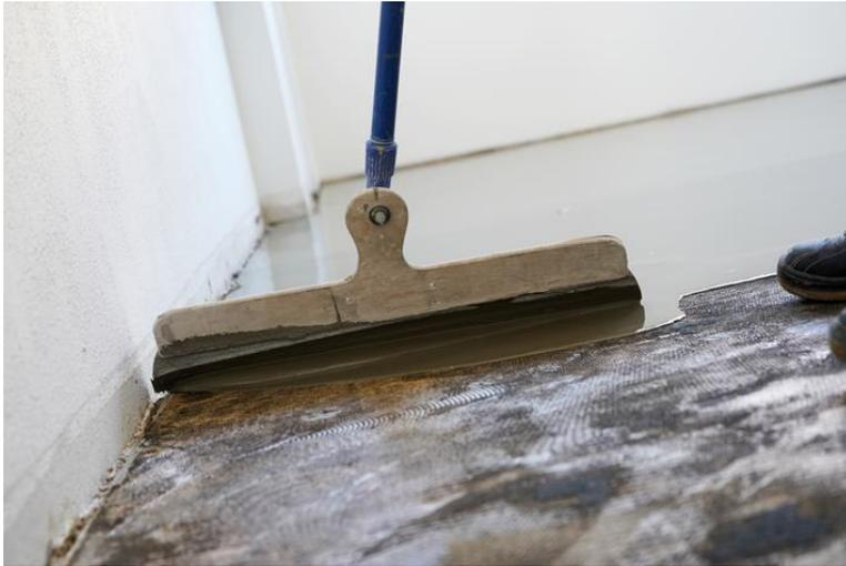
Mit einem Ausbreitmaß von 36 bis 38 cm eignet sich der HASIT FN 645 hervorragend als Verbundausgleich auf Beton oder zum Glätten, Spachteln oder Egalisieren von Estrichen.
