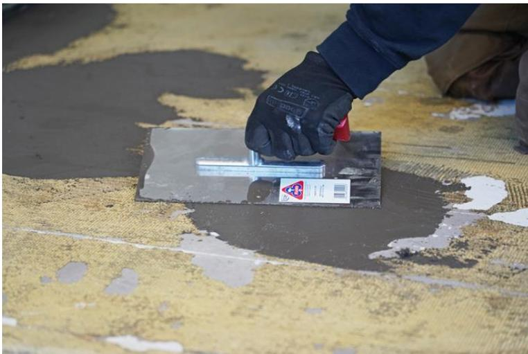
Größere Fehlstellen werden zuvor ausgebessert – im System bleibend, ebenso mit dem HASIT FN 645.
