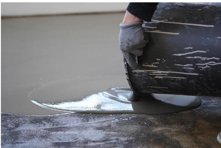
Den HASIT FN 645 zeichnet eine honigartige Konsistenz aus. Nahezu selbstnivellierend genügt ein kurzes Nacharbeiten mit der Stachelwalze beziehungsweise Schwabbelstange zur perfekten, belegereifen Oberfläche.
