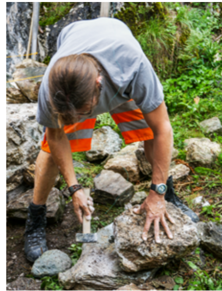
Einige der für die Mauer ausgewählten Bruchsteine gilt es zuerst noch zu bearbeiten.
