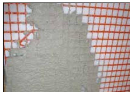
Das vormontierte Stützgewebe wird mit RÖFIX AeroCalce IA 782 THERMO Hydraulkalk-Wärmedämmputz 30 mm stark oder mit RÖFIX AeroCalce IA 784 PLUS 10 mm dick überputzt.
