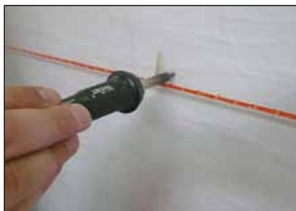
Mit geeignetem Schneidegerät mit heisser Klinge oder mit einem Lötkolben ein kleines Loch in die Vliesmatte einbrennen.
