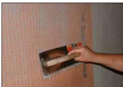
RÖFIX P50 Armierungsgewebe wird in RÖFIX AeroCalce IA 784 PLUS eingespachtelt.
