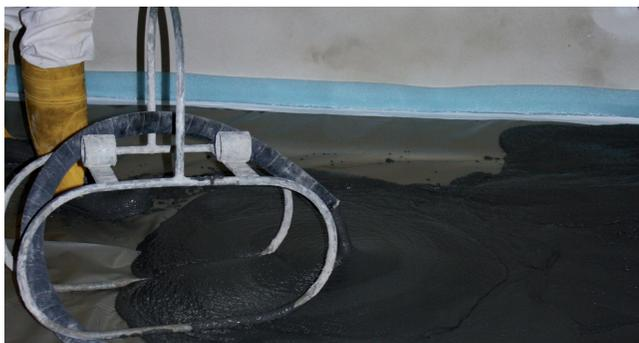
RÖFIX ArtFloor wird mittels Maschinenteknik eingebracht
