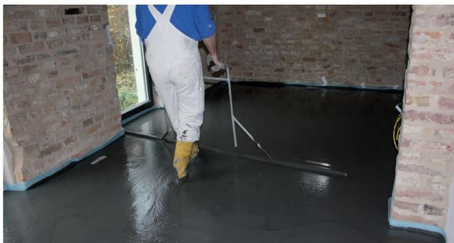
RÖFIX ArtFloor mittels Schwabbelstange nivellieren
