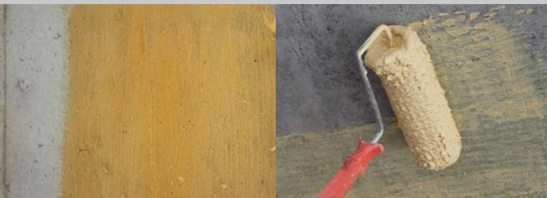
Ein Ausgleichsputz ist qualitativ die beste und sicherste Lösung. Dabei werden die Poren im Beton verschlossen und eine Blasenbildung bei der nachfolgenden Beschichtung mit Gips- oder Kalk-Zementputzen ist so gut wie ausgeschlossen. Der Fixit 454 Multipro Haft- und Renoviermörtel und die Fixit 343 Quarzhaftbrücke universal eignen sich dafür hervorragend.
