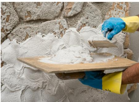
6. Gesamtputzdicke maximal 40 mm
