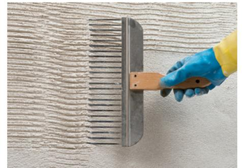
5. Grundputz in Lagen von 20 mm bearbeiten; sind grössere Versalzungen festgestellt worden, muss der Sanierputz in 2 Lagen (1 Woche Wartezeit pro cm Schichtaufbau) appliziert werden
