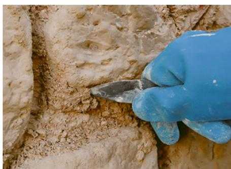
1. Salzbelasteten Putz bis 1 m oberhalb der Schadensgrenze bis auf das Mauerwerk entfernen
