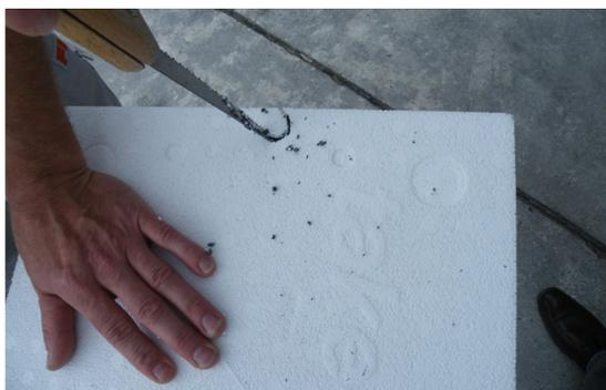
Sciez les bouchons adaptés au trou de l'échafaudage à l'aide d'une scie sauteuse et vérifiez que la taille est correcte. En général, le bouchon devrait être plus grand que le trou original.
