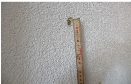
Retirez les particules de mortier détachées du trou de l'échafaudage et mesurez la taille du trou.
