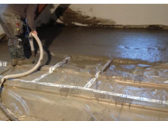
Isolazione termica e uguagliamento delle altezze di vecchi pavimenti in assito
