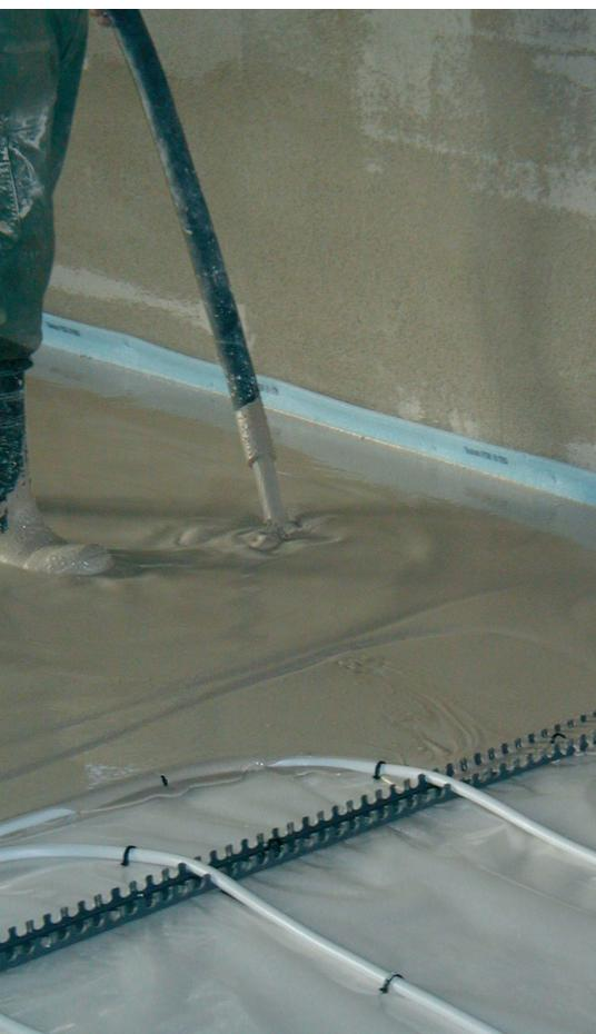
Miscelato negli stabilimenti Fixit, il CAF è una malta secca, pronta all'uso che garantisce le esigenze qualitative più elevate. Il prodotto è fornito in sacchi oppure sfuso in silo eventualmente dotato di apposita attrezzatura per miscelazione e pompaggio.
