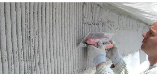
Applicare l'intonaco di finitura minerale in un senso con una talocchia dentata R 16 (2 mm) e R 20 (4 mm) per ottenere uno spessore uniforme (a seconda della granulometria)
