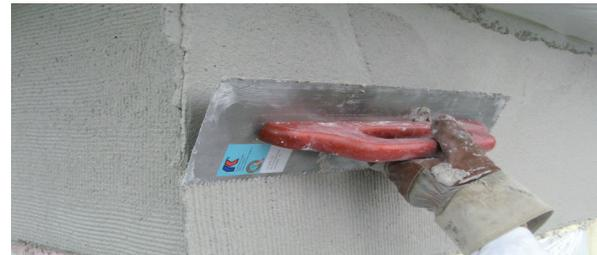
Dopo un'essiccazione sufficiente (da 12 a 24 ore in base la temperatura e alle condizioni atmosferiche), grattare la superficie con l'apposito grattone Fixit.
