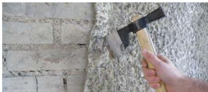
Rimuovere completamente il rivestimento fino a 80 cm al di sopra del punto danneggiato
