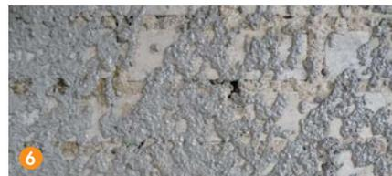
Applicare il rinforzo a base cemento Fixit 211 con copertura della superficie pari a 50% circa.
