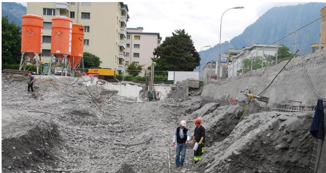
Fixit 526 A Beton secco a spruzzo per il consolidamento di scavi C25/30 et Fixit 530 Malta per iniezioni
