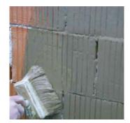
Rajasil Boue d'argile est appliqué sur des supports bien absorbants et porteurs (par ex. la brique en terre cuite et le béton cellulaire).
