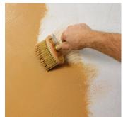
Après séchage du système dienduit argileux, il se peut que le Rajasil Enduit argileux s'effrite l'égèrement et que de petites fissures de retrait se forment.
