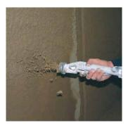
Rajasil Enduit argileux fin est ensuite appliqué, en épaisseur de couche appropriée, sur la boue d'argile humide. L'application se fait à la machine à enduire ou à la main en couche de
