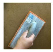
Rajasil Enduit argileux fin peut ensuite être appliqué sur l'enduit de fond argileux humidifié. Ici également, il faut préalablement verser Rajasil Boue d'argile et appliquer l'enduit argileux frais sur frais. Durant le séchage, la surface d'enduit peut être feutrée à l'aide d'une taloche à éponge. En étant préalablement humidifiée, la surface de benduit argileux peut également être retravaillée ultérieurement.
