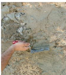
Die que le mortier a séché sur le support, le mortier de bourrage doit être gratté
