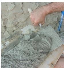
Le lendemain, les travaux peuvent continuer avec l'application de l'enduit de fond. Il est projeté à la main ou appliquée à la machine.
