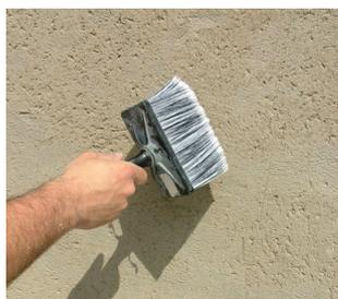
Humidifier l'enduit de fond afin que le crépi de finition ne devienne pas poreux.
