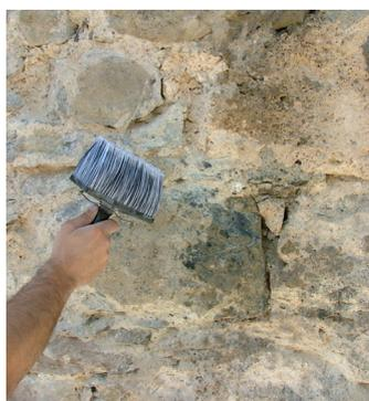
La maçonnerie doit être pré-humidifiée avant d'être bouchée.
