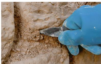
Salzbelasteten Putz bis 1 m oberhalb der Schadensgrenze bis auf das Mauerwerk entfernen.
