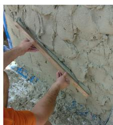
Anschliessend wird der Grundputz mit der Holzlatte oder mit der Kellenrückwand plangezogen.
