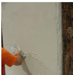
Der Deckputz wird aufgezogen und kann geglättet, abgerieben oder mit der Bürste bearbeitet werden.
