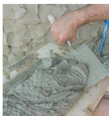
Am nächsten Tag kann mit dem Grundputz weitergearbeitet werden. Dieser wird von Hand angeworfen oder maschinell aufgetragen. Den Untergrund vorgängig vornäsen.
