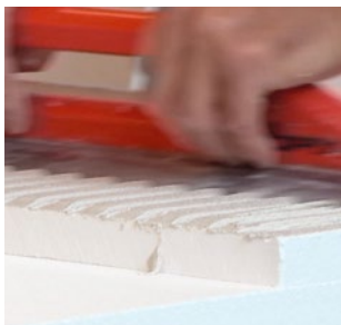
3 Incollaggio dei pannelli isolanti
