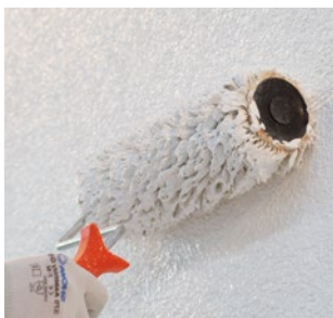
7 Pitturazione con pitture altamente permeabili al vapore
