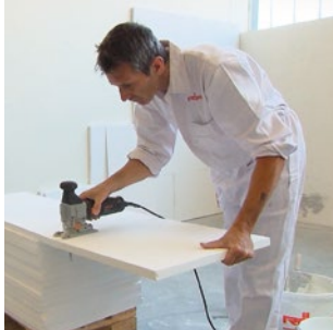
2 Preparazione dei pannelli
