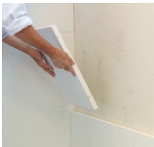
4 Applicazione dei pannelli isolanti
