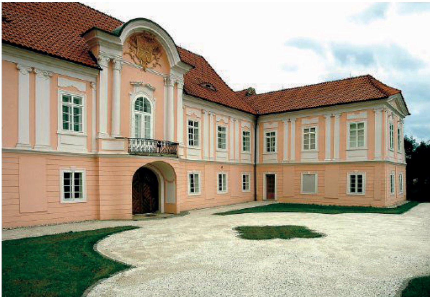
Sanace a renovace
