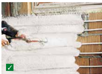
✓ Wandheizungs-Einbindung in Putz RÖFIX Renoplus®
