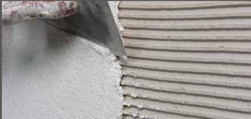
RÖFIX 772 Kratzputz über den mit Zahntraufel vorbereiteten System- Klebe- und Armierungsmörtel aufziehen
