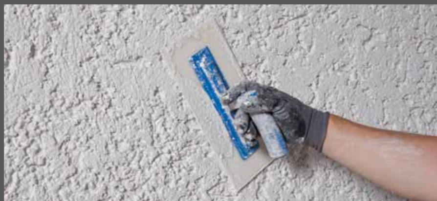
Variante: RÖFIX 750 Kellenwurf nach dem Anwurf verreiben
