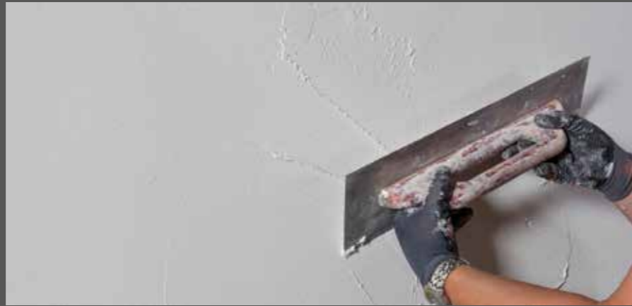
RÖFIX System- Klebe- und Armierungsmörtel aufziehen
