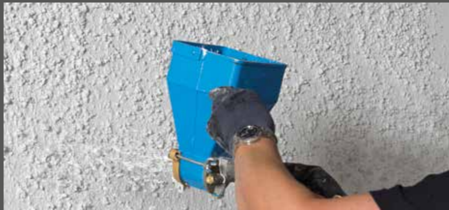
RÖFIX 750 Kellenwurf maschinell aufspritzen
