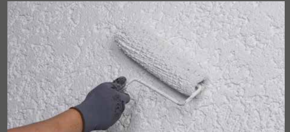
RÖFIX 750 Kellenwurf grundieren und zweimal mit RÖFIX Fassadenfarbe streichen
