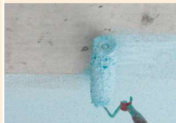
Appliquer les ponts d'adhérence à pleine surface
