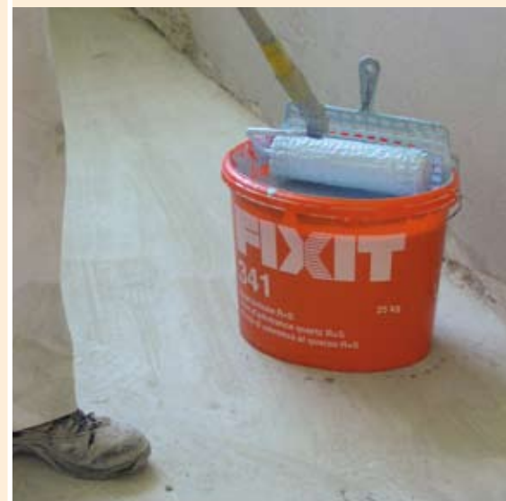
Appliquer les ponts d'adhérence à pleine surface
